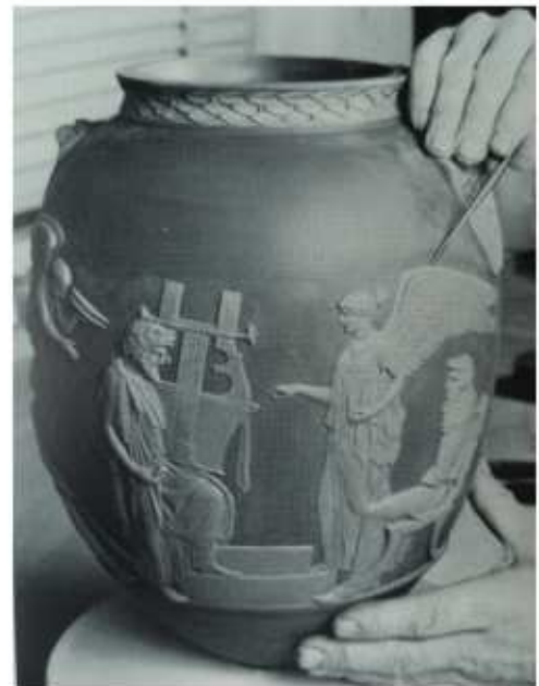
Abb. 108: Nachbearbeitung des angelegten Reliefzierrats
