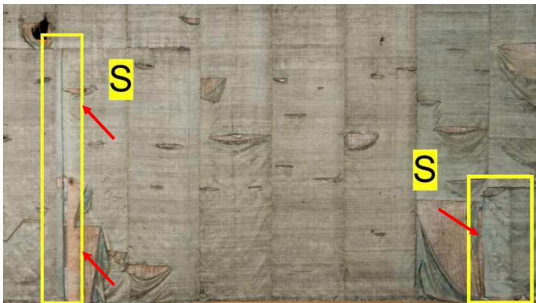
Abbildung 45: SZ/SW/WF1: Eingesetzte Bereiche mit S-Grat stechen farblich heraus.
