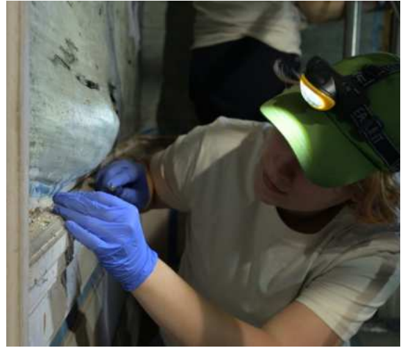
Abbildung 104: Lösen der Nägel unter der Schmutztasche
