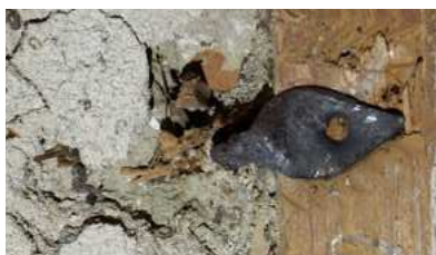
Abbildung 28: SZ/SW/WF2: Mauerhaken an der Mittelleiste
