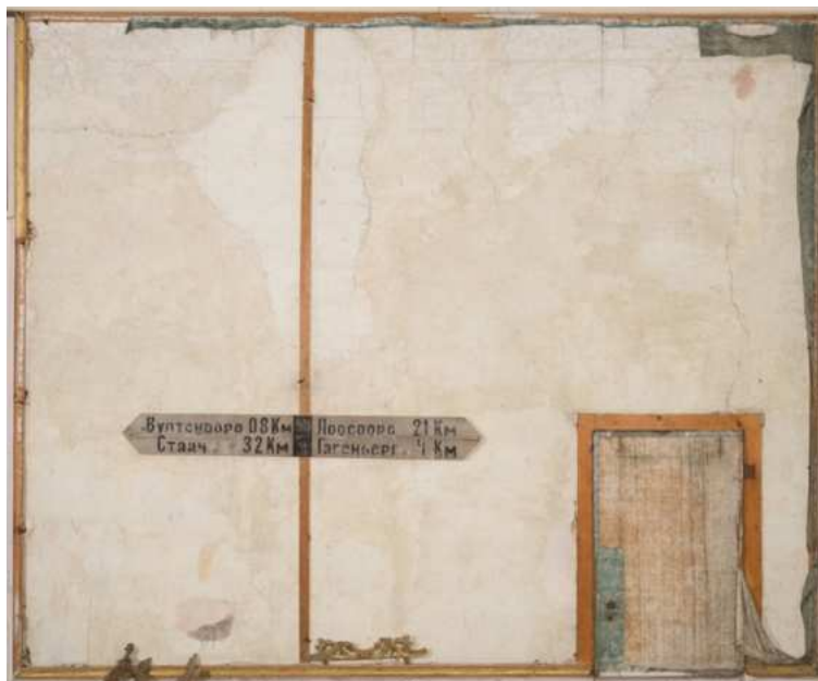
Abbildung 30: SZ/NW/WF2: Verlauf der Blindleisten
