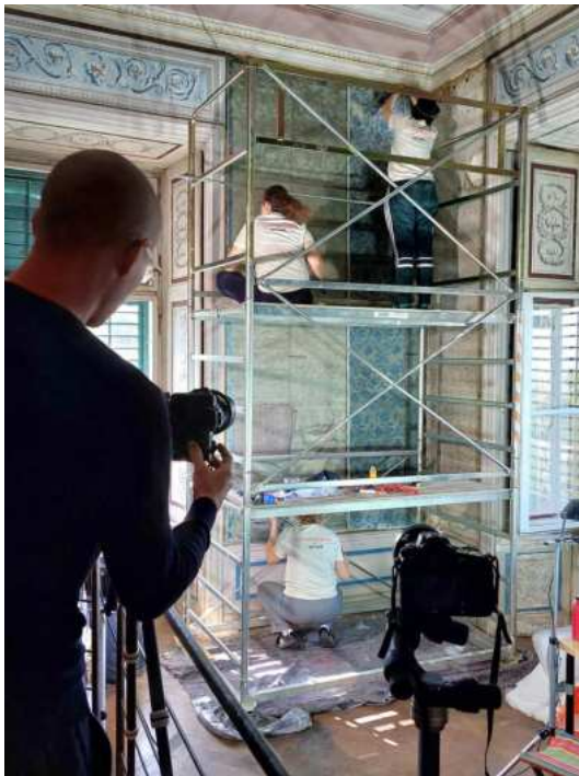
Abbildung 110: Fotografische Dokumentation der Demontage
