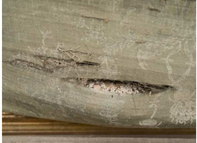
Abbildung 63: SZ/SW/WF2: Nahaufnahme der mit Schutt gefüllten Schmutztasche
