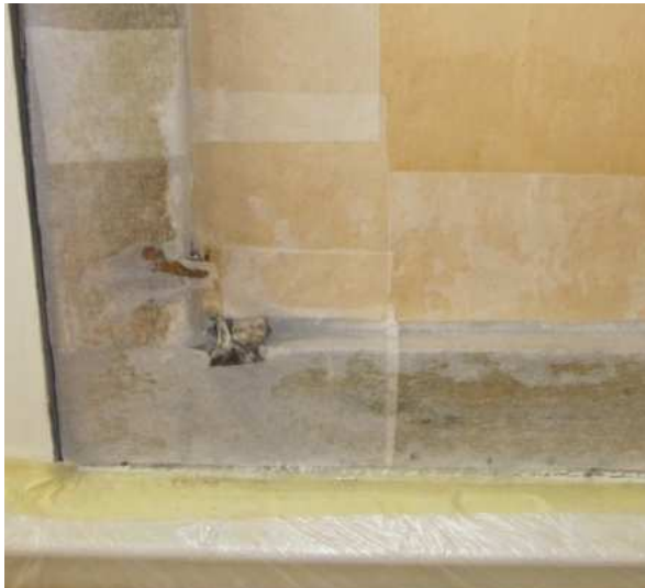
Abbildung 100: Beispiel der Anbringung von Makulaturpapier zwischen Blindleisten und Wandfläche als Schutzmaßnahme
