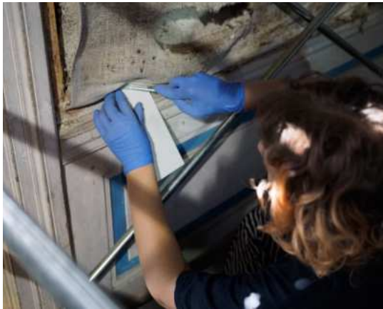
Abbildung 108: Demontage der Leinenunterbespannung
