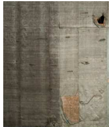
Abbildung 66: SZ/SW/WF1: Geradliniger Verlauf der Verschwärzung
