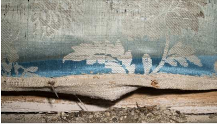
Abbildung 69: Originaler Farbton des Seidengewebes unterhalb der Zierleiste
