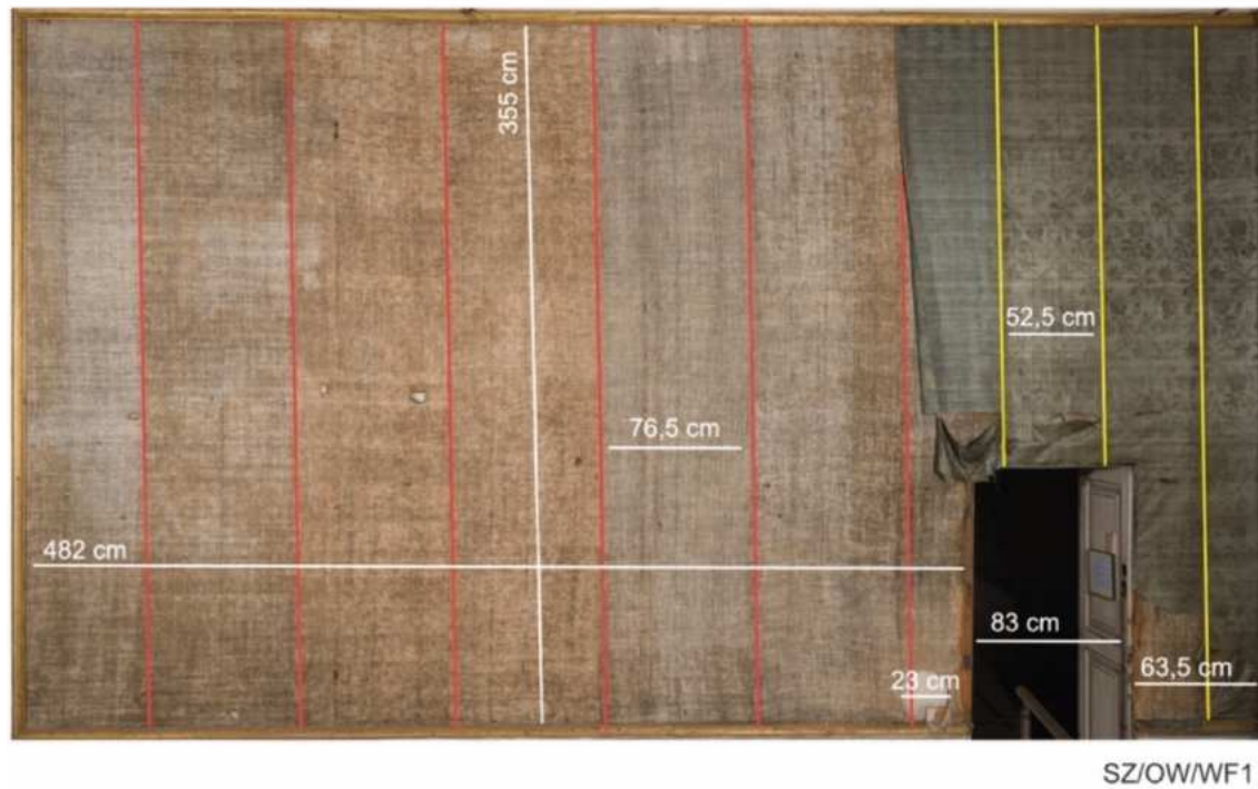
Abbildung 11: Wandfeld der Ostwand mit Einzeichnung der Maße und Verlauf der Nähte (rot: Leinen; gelb: Seide)
