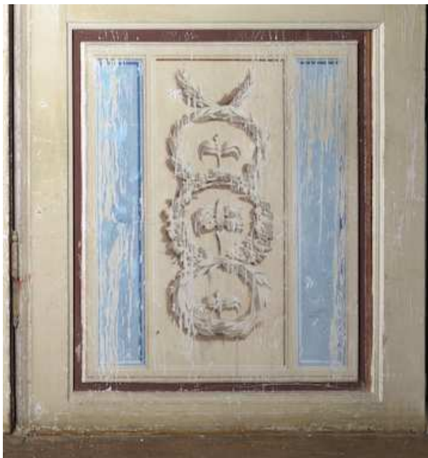
Abb. 88 Detail Tür Kleiner Salon - Scherbenzimmer, Laibung, Ostseite
