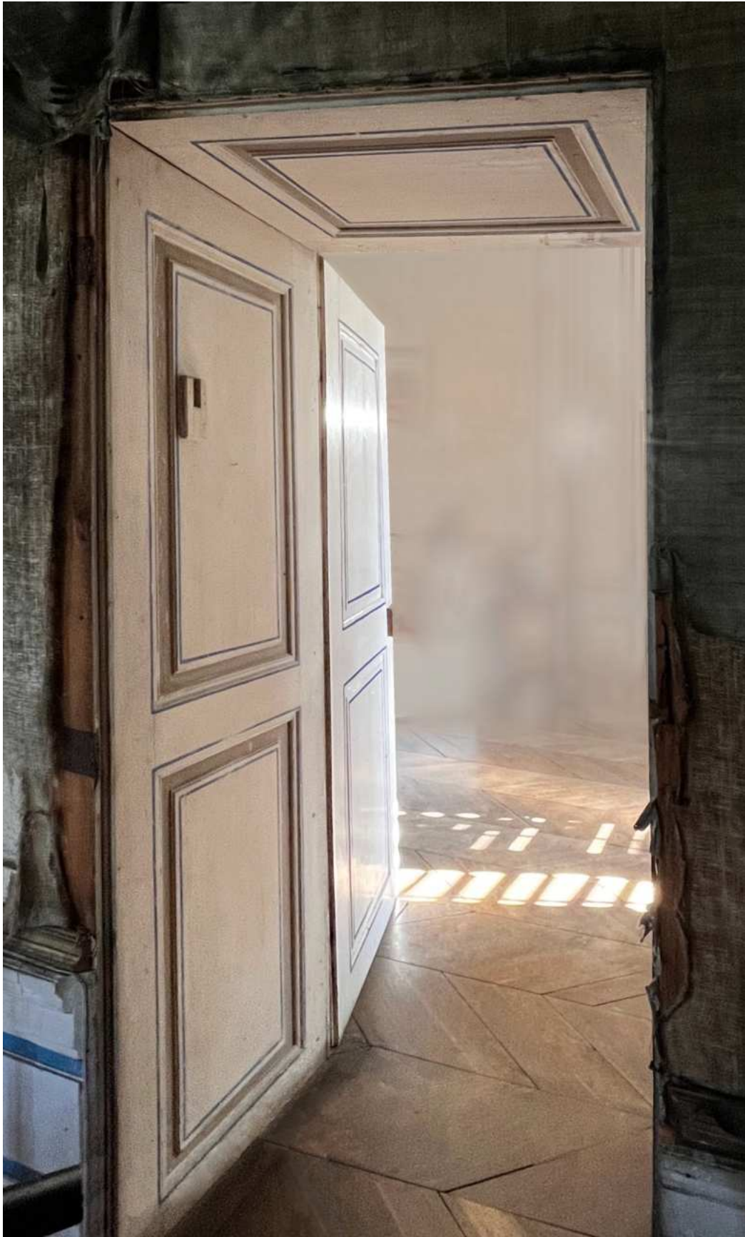
Abb. 178 Tür Scherbenzimmer – Jagdspeisezimmer, Laibung, Sturz und Türblatt
