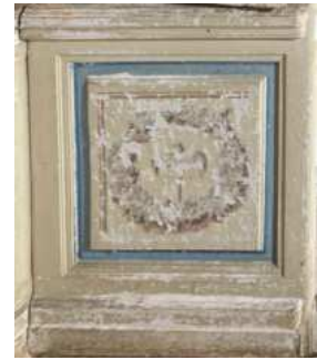
Abb. 77 Scherbenzimmer, linkes Fenster Westseite, rechts
