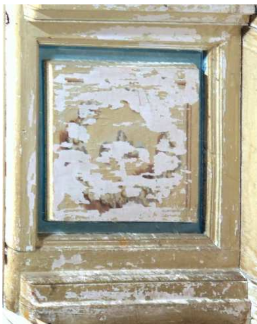
Abb. 159 Scherbenzimmer, Fenster Südseite, Sockel, links
