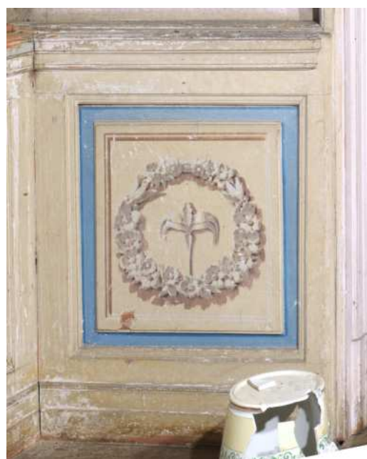
Abb. 142 Scherbenzimmer, rechtes Fenster Westseite, rechts
