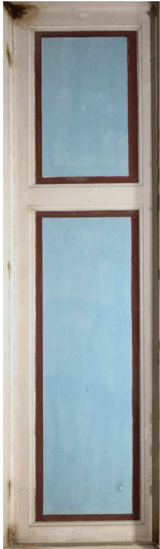
Abb. 156 Scherbenzimmer, Fenster Südseite, Laibung, rechts
