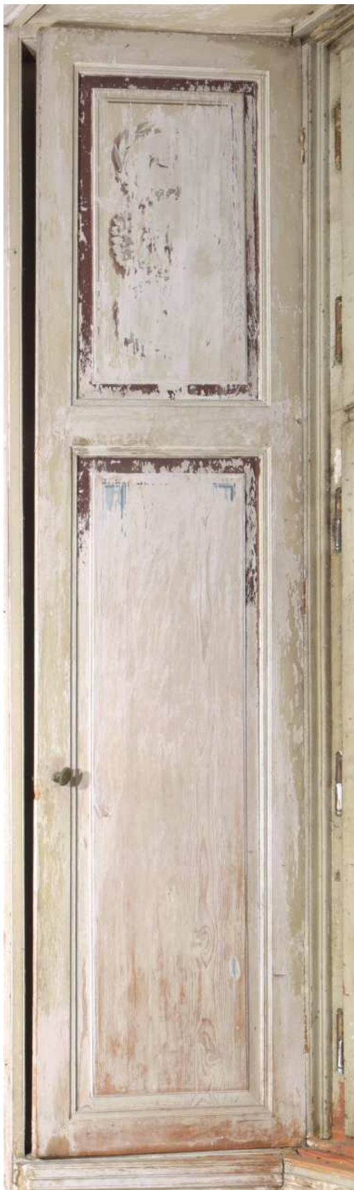
Abb. 134 Scherbenzimmer, rechtes Fenster Westseite, Fensterladen, Vorderseite, links
