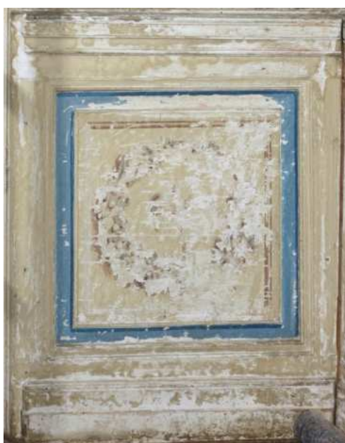
Abb. 150 Scherbenzimmer, linkes Fenster Westseite, Sockel, links
