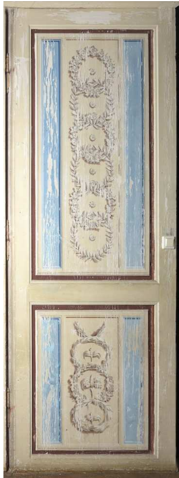
Abb. 175 Tür Kleiner Salon - Scherbenzimmer, Laibung, Ostseite
