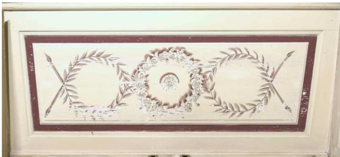
Abb. 157 Scherbenzimmer, Fenster Südseite, Sturz
