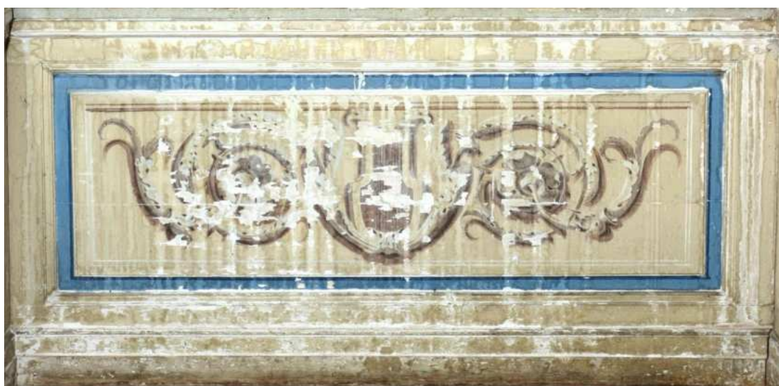
Abb. 158 Scherbenzimmer, Fenster Südseite, Sockel, Mitte
