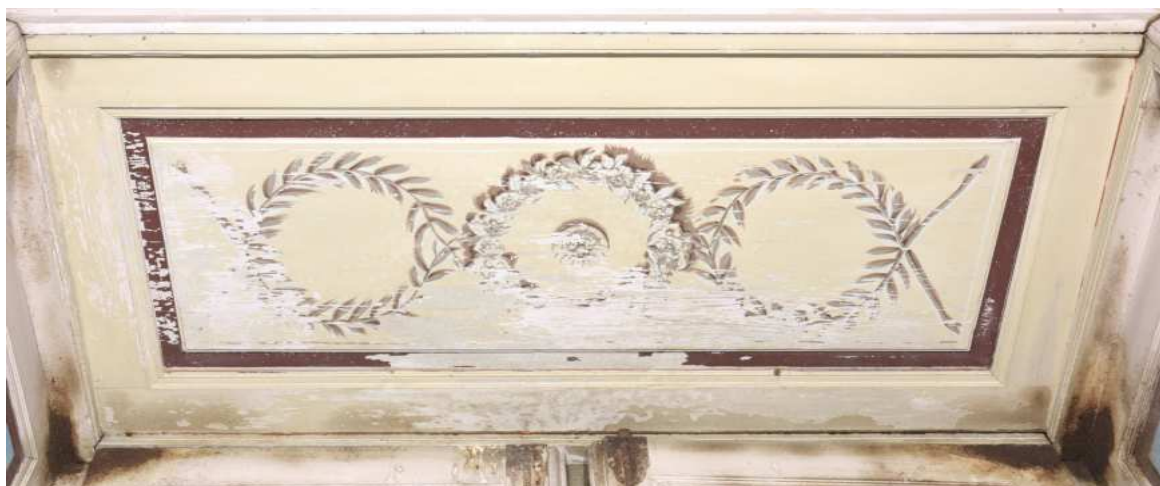
Abb. 139 Scherbenzimmer, rechtes Fenster Westseite, Sturz
