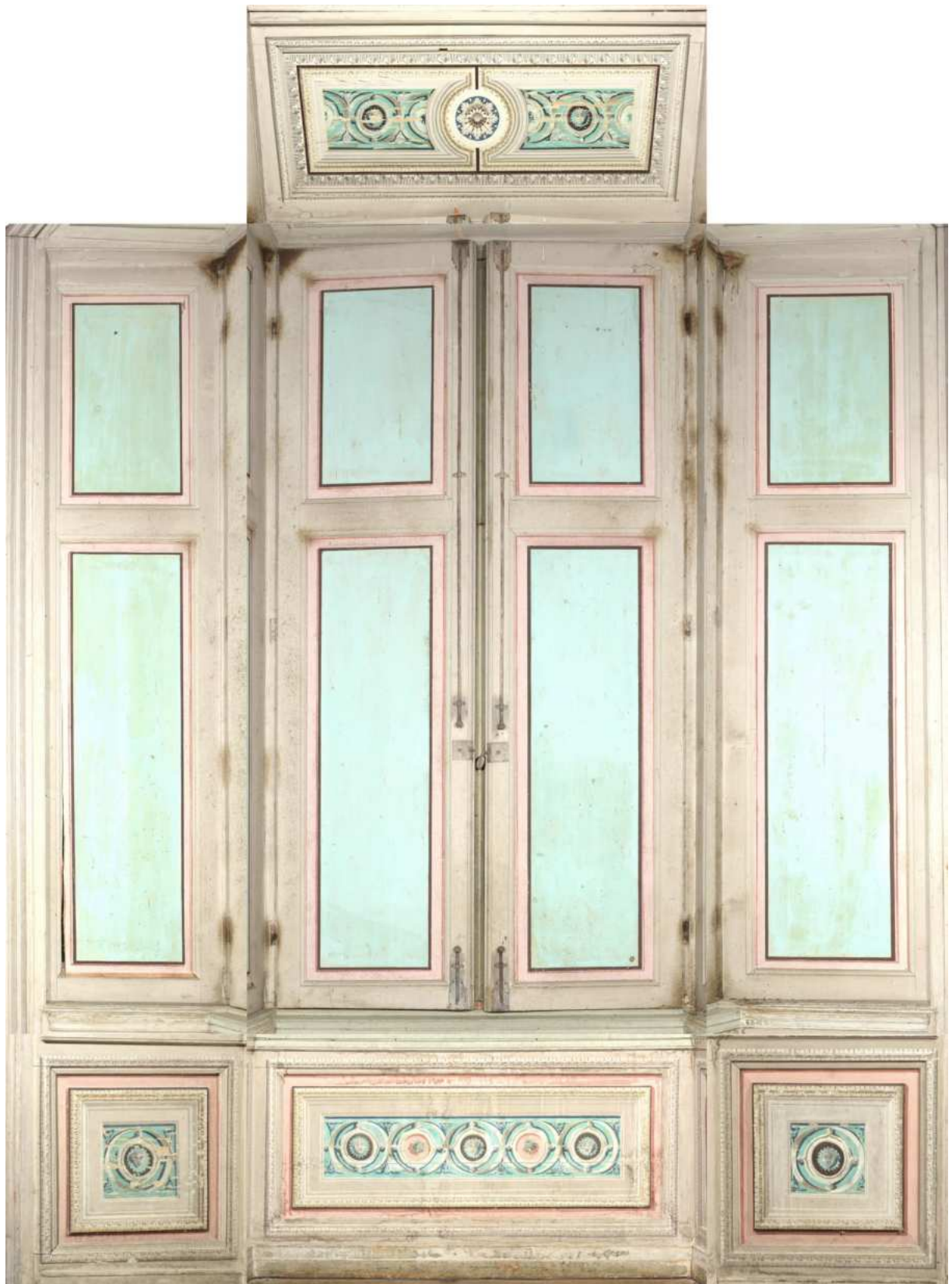
Abb. 5 Kleiner Salon, Fenster, Fensterläden Rückseite und Laibung
