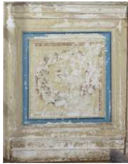
Abb. 75 Scherbenzimmer, linkes Fenster Westseite, Sockel, links
