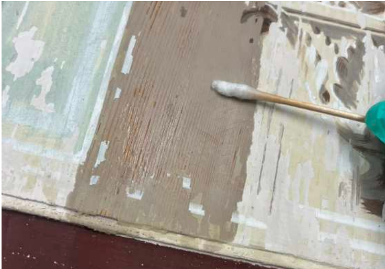
Abb. 122 Hydrophobierung mit Shellsol T mit Wattestäbchen
