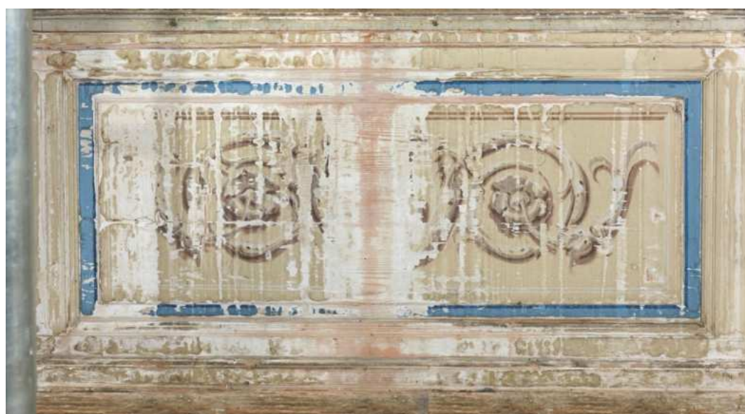
Abb. 149 Scherbenzimmer, linkes Fenster Westseite, Sockel, Mitte
