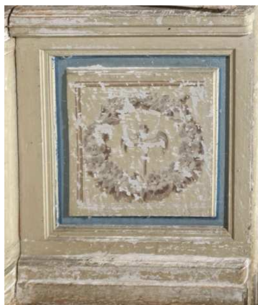
Abb. 151 Scherbenzimmer, linkes Fenster Westseite, rechts
