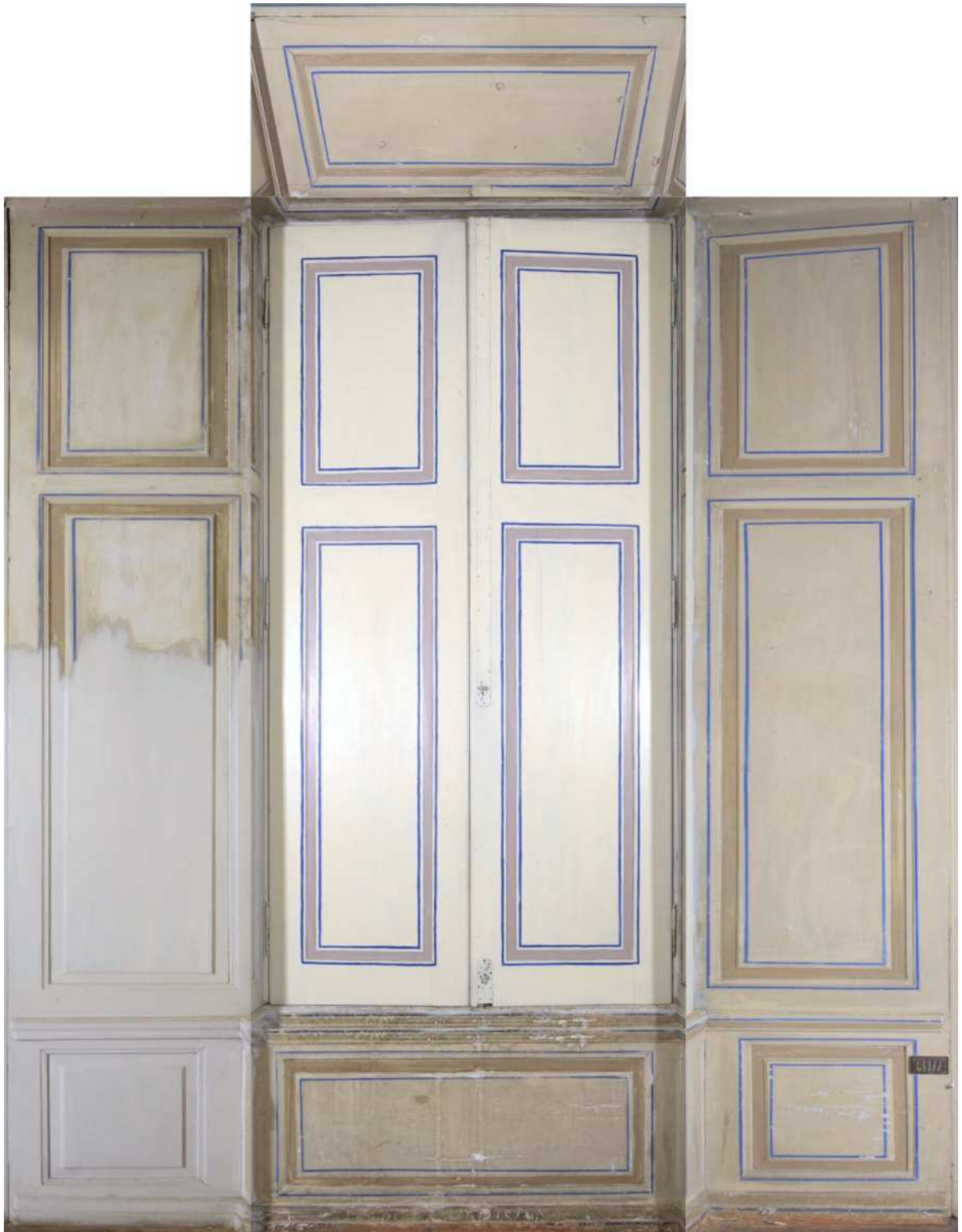
Abb. 18 Jagdspeisezimmer, Fenster, Fensterläden Rückseite und Laibung
