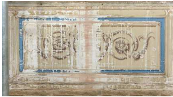
Abb. 76 Scherbenzimmer, linkes Fenster Westseite, Sockel, Mitte
