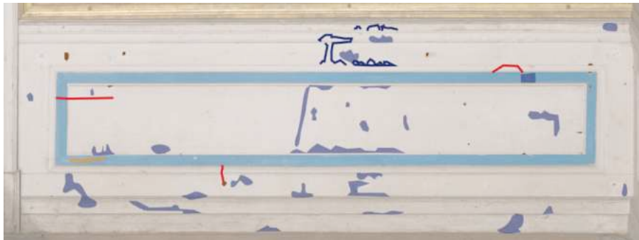
Abb. 83 Kartierung: Scherbenzimmer, Sockel, rechts neben Fenster Südseite
