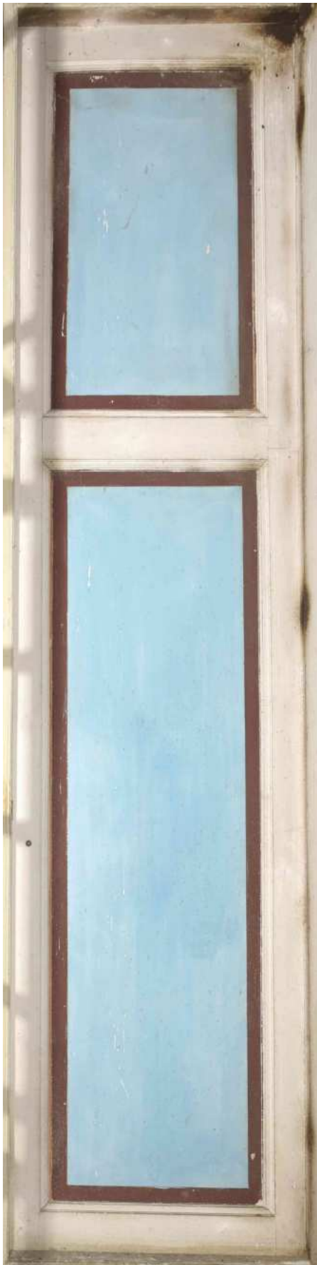
Abb. 146 Scherbenzimmer, linkes Fenster Westseite, Laibung, links
