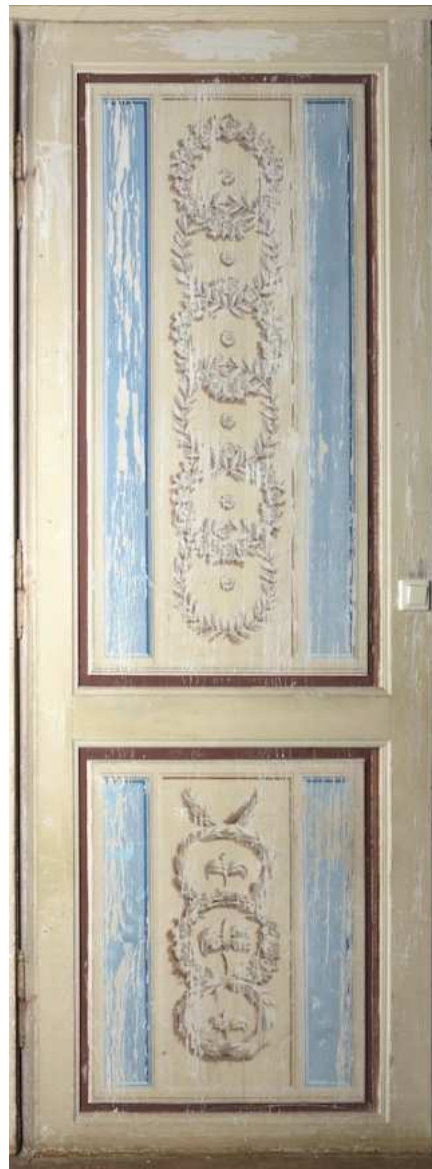
Abb. 25 Tür Kleiner Salon - Scherbenzimmer, Laibung, Ostseite
