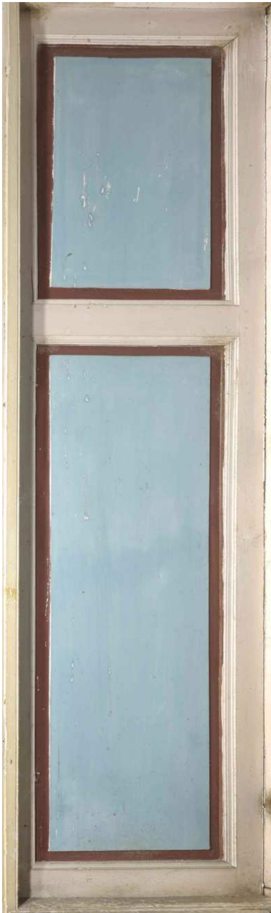
Abb. 155 Scherbenzimmer, Fenster Südseite, Laibung, links
