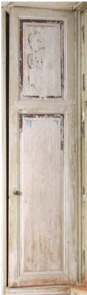
Abb. 71 Scherbenzimmer, rechtes Fenster Westseite, Fensterladen, Vorderseite, links
