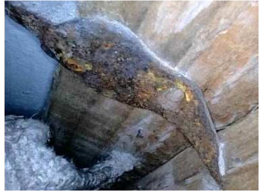
Abb. 35: Korrodierter Metallhaken
