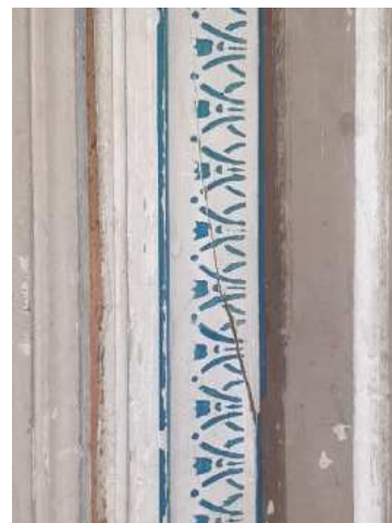
Abb. 38: Sprung in der Zierleiste
