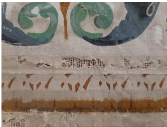
Abb. 55 Verlust des Papiers durch Schädlinge (Südwand)
