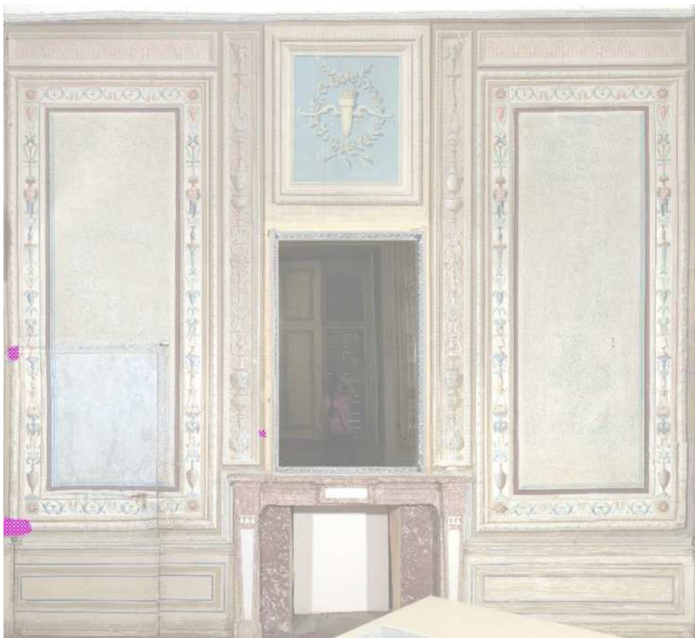
Abb. 63: Flicken in Körperbindung, Nordwand
