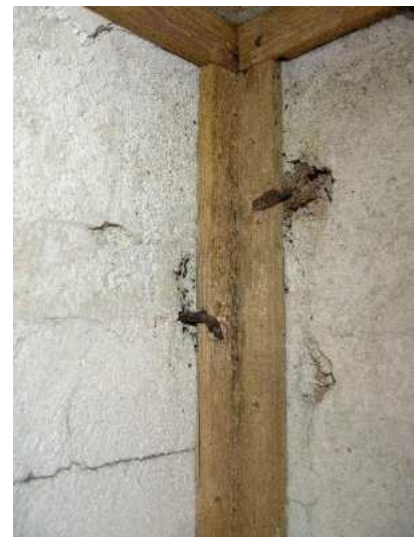
Abb. 16: Montierte Leisten der Wandbespannung im Scherbenzimmer
