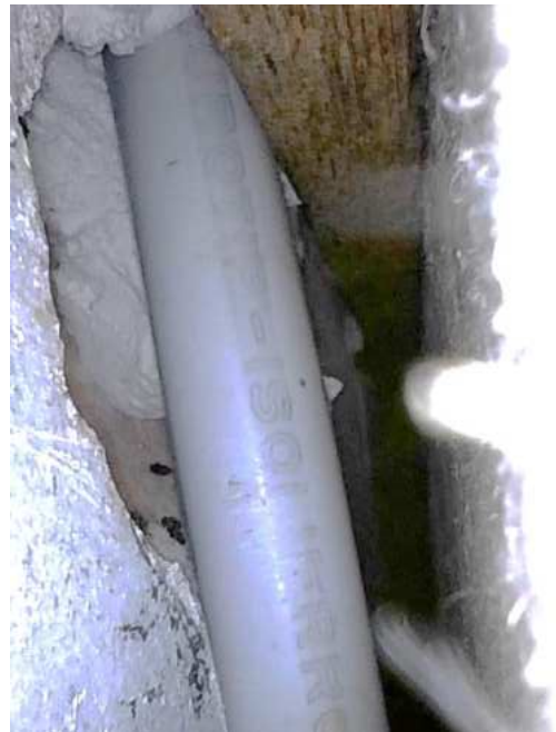
Abb. 36: Leitungsrohr zwischen der horizontalen Holzleiste und der Wand (Ostwand)
