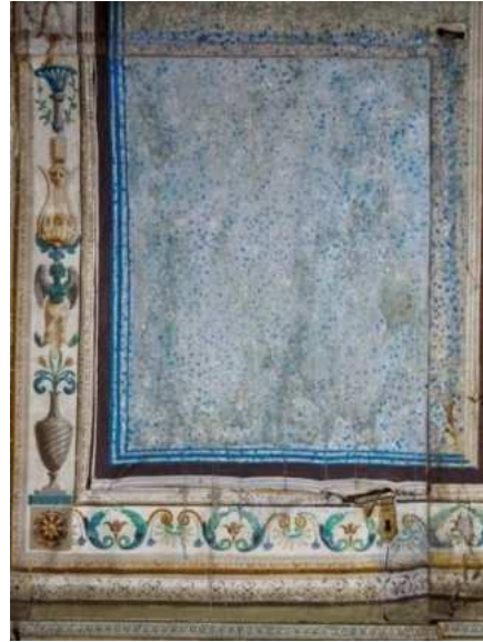
Abb. 61: Retusche bei der Tapetentüre
