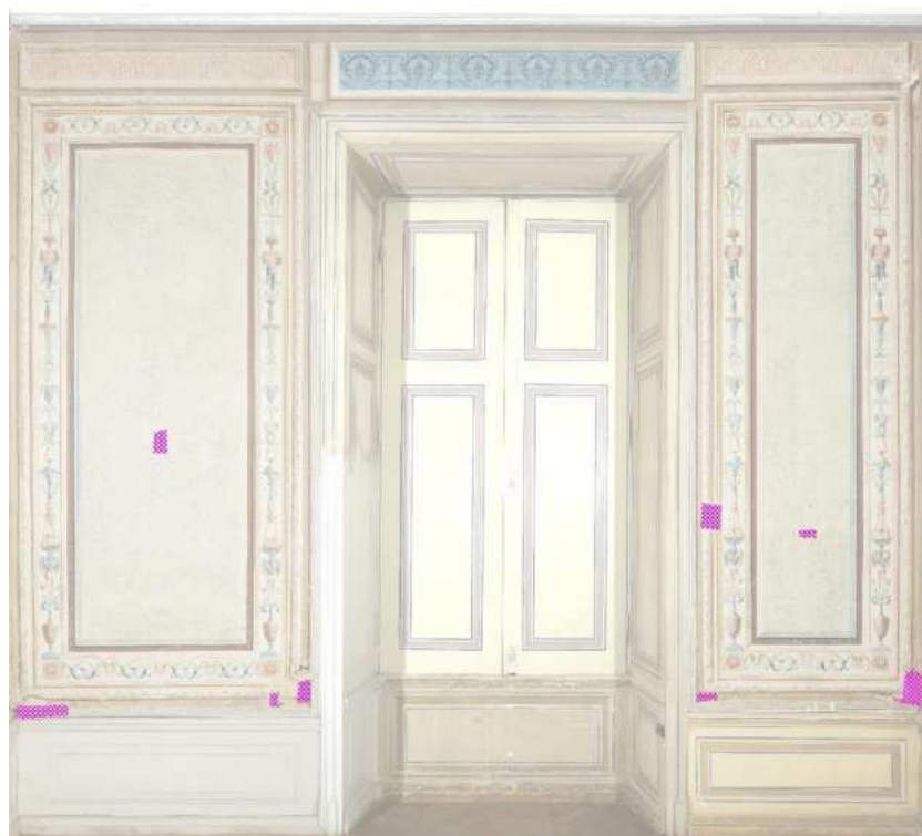
Abb. 65: Flicken in Körperbindung, Südwand
