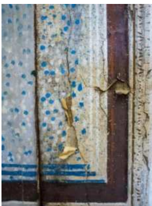
Abb. 51: gerissenes Papier, das sich von der intakten Leinwand darunter löst (Tapetentür)
