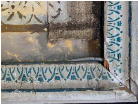
Abb. 37: Verschmutzte und gebrochene Zierleiste
