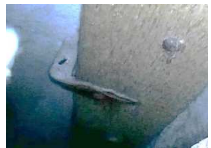
Abb. 14: Befestigung der Leisten
